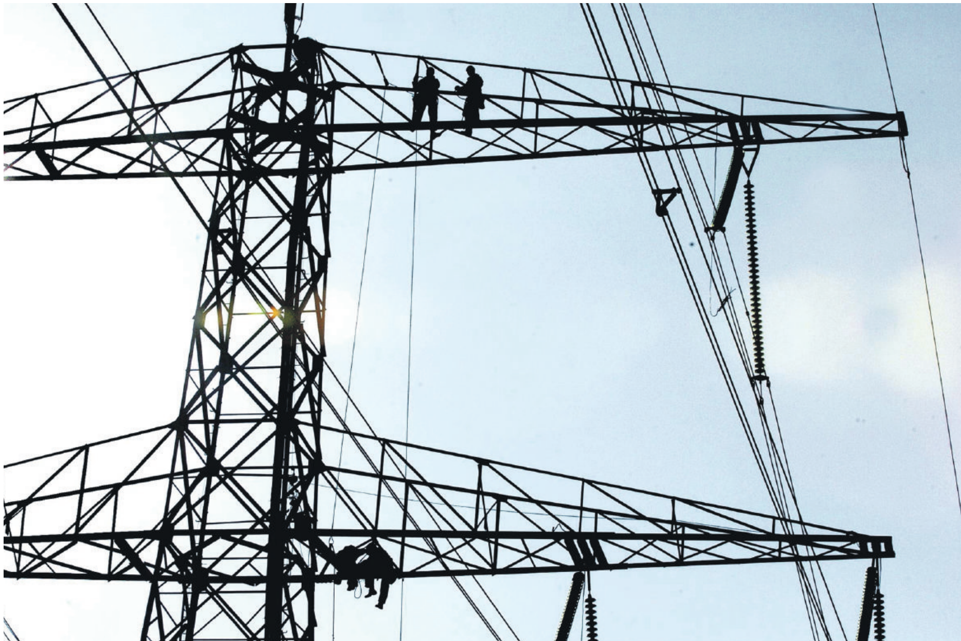
Werkzaamheden aan een hoogspanningsmast.
